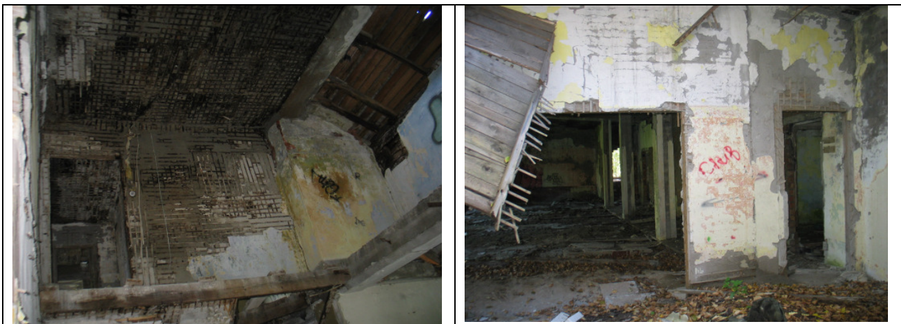
4.1.6. Būve 016 . Angāra ēka daļēji demontēta. Saglabājušies silikātu ķieģeļu mūra sienu fragmenti un betona pamati.
