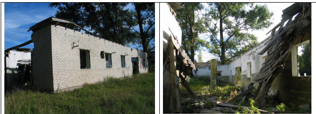
4.1.7. Būve 017 . Barības virtuves ēka no silikātu ķieģeļu mūra nesošajām sienām. Būvei ir betona pamati. Jumta konstrukcijas būvei ir iebrukušas daļēji demontētas. Durvju un logu konstrukcijas demontētas.
