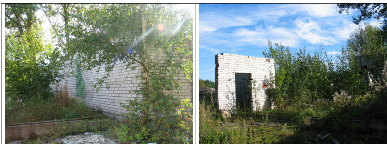
4.1.7. Būve 017 . Barības virtuves ēka no silikātu ķieģeļu mūra nesošajām sienām. Būvei ir betona pamati. Jumta konstrukcijas būvei ir iebrukušas daļēji demontētas. Durvju un logu konstrukcijas demontētas.
